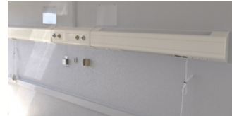
Sustitución luminaria y central de comunicación paciente-enfermería.
